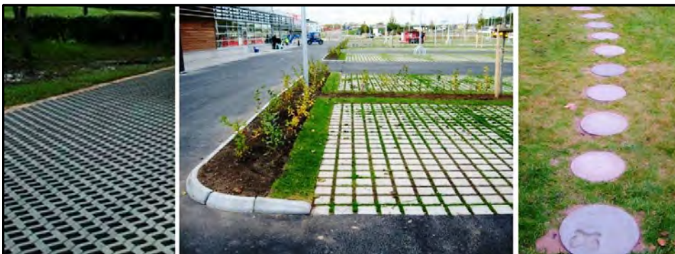
Figur 14.6: Ytor med hålsten av betong samt gångstig med gräs och gångplattor.
