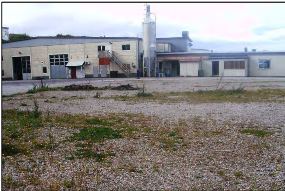
Figur 13.2: Industrihotellets östra sida med pelletstorn.
